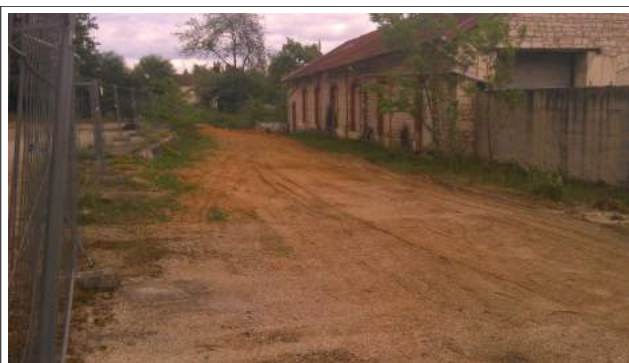
Terrassement de la zone des cuves
