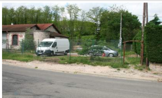
Clôture et accès piéton
